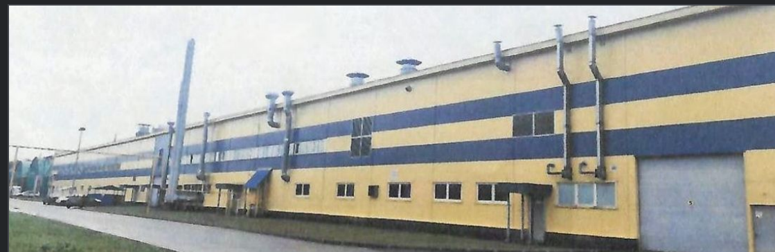
Производственные корпуса: ворота в каждом помещении 09 · Индустриальная площадка Всеволожск
