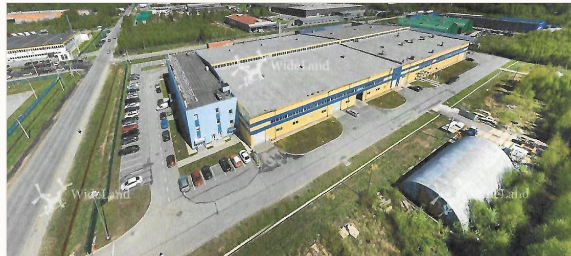
113 · Комплекс ЛСЗ — действующий, введён 2008–2014 · 14 718 м 2 , собственная энергетика, работающие арендаторы
