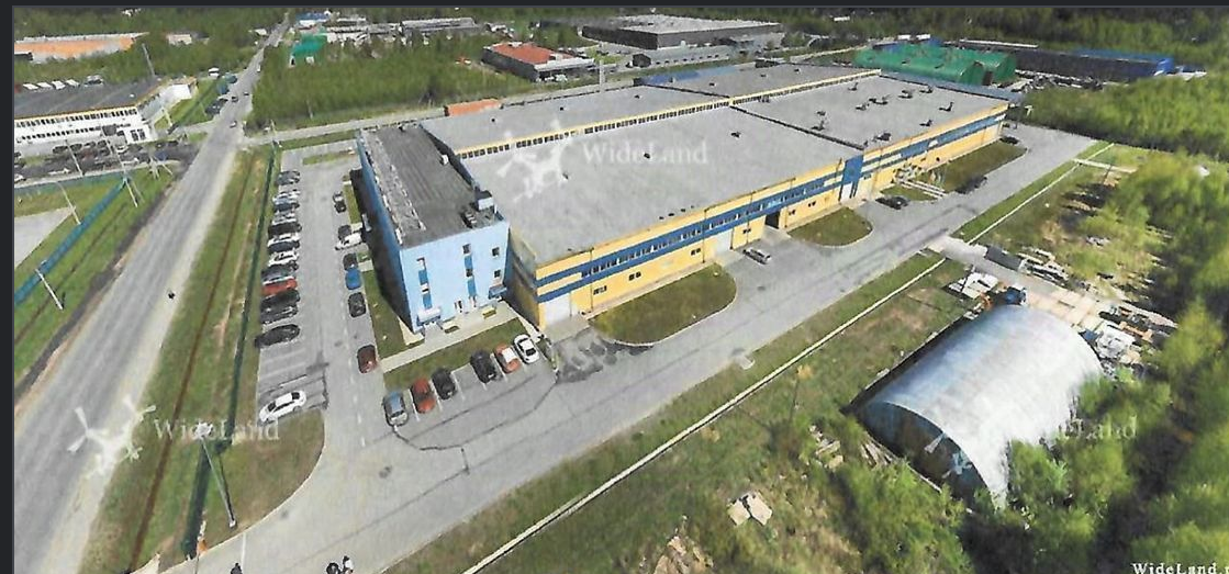
АБК, производственные корпуса, тёплый склад
